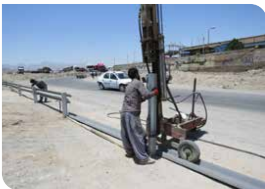
نصب گارد ریل جهت جلوگیری از تخلیه غیرمجاز خاک و نخاله (انتهای فلکه پنجم آزادشهر، دورگرد پل تقوی) به متر اژ یک کیلومتر با هزینه بالغ بر ۲۵۰ میلیون ریال - تهیه پایه توسط شهرداری و ۷۵۰ میلیون ریال هزینه اتصالات توسط اداره کل راه و شهرسازی
