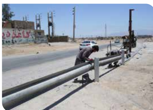
نصب گارد ریل جهت جلوگیری از تخلیه غیرمجاز خاک و نخاله (انتهای فلکه پنجم آزادشهر، دورگرد پل تقوی) به متر اژ یک کیلومتر با هزینه بالغ بر ۲۵۰ میلیون ریال - تهیه پایه توسط شهرداری و ۷۵۰ میلیون ریال هزینه اتصالات توسط اداره کل راه و شهرسازی
