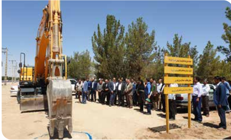
اجرای خط انتقال پساب تصفیه شده به فضای سبز شهری
